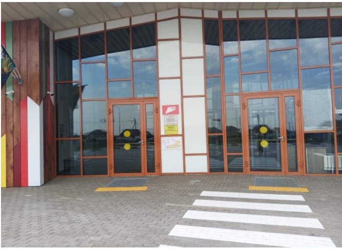
Фото 6. Входная площадка (перед дверью)
